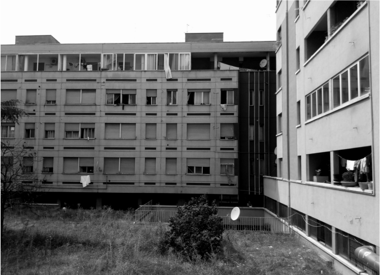
Palazzi via Paradisi
